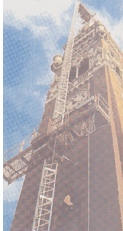
Figura 8 Esempio di ponteggio autosollevante
