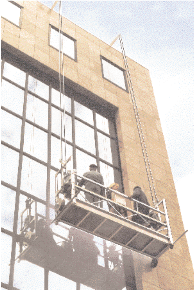
Figura 9 Esempio di ponteggio motorizzato
